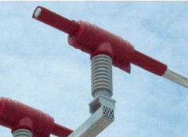
2 MVLC-38 на круглой шине вместе с корпусом BCIC
