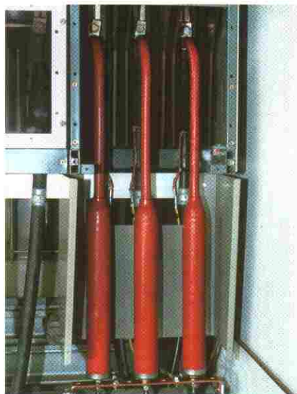
Ячейка РУ с типовым кабельным вводом и ОПН серии SPA-I
