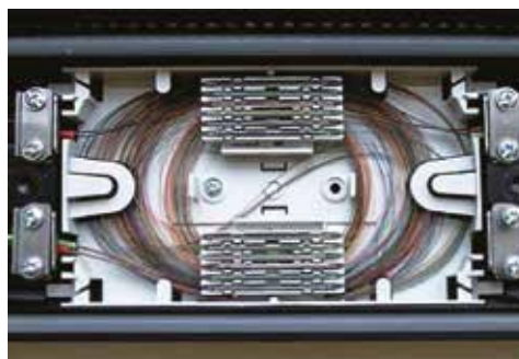
Зона соединений для 24 оптических волокон
